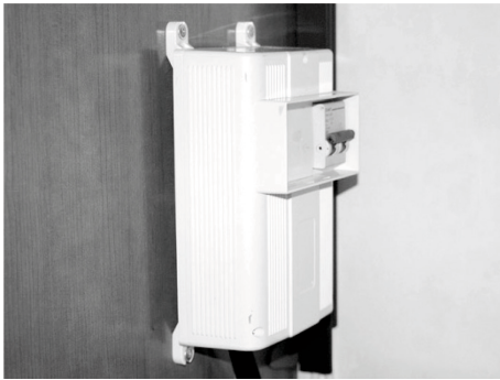
Abb. 3: Hauptschalter (FI-Schutzschalter)
